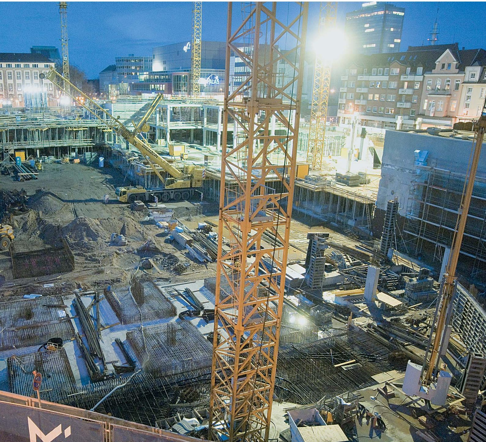
Die Großbaustelle des Forums ist nach dem CityPalais der nächste Markstein für die Innenstadtentwicklung.
